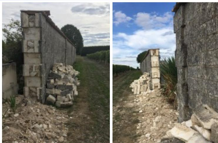
Mur Ouest du cimetière exposé à l'eau en permanence. Suite à la chute de pierres, il a été procédé à la reprise intégrale de 7.50 m sur poutre béton.
