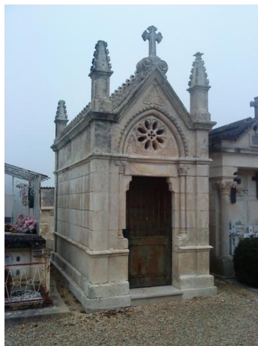
Nouveau caveau communal anciennement chapelle dite « Virollaud ».
